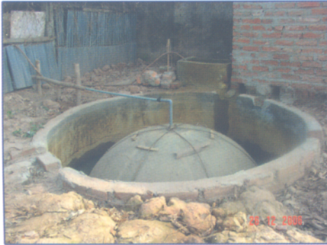
Công trình gia đình (ngoài trời)
