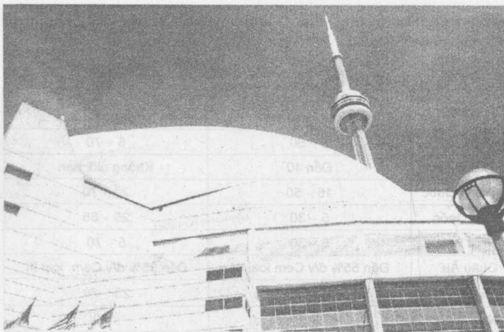
Hình 21a. Tòa nhà Skydome tại Toronto (Canada) xây dựng năm 1989 sử dụng bê tông – xỉ trong đó xỉ hạt cao đã thay thế 25% xi măng Portland.
