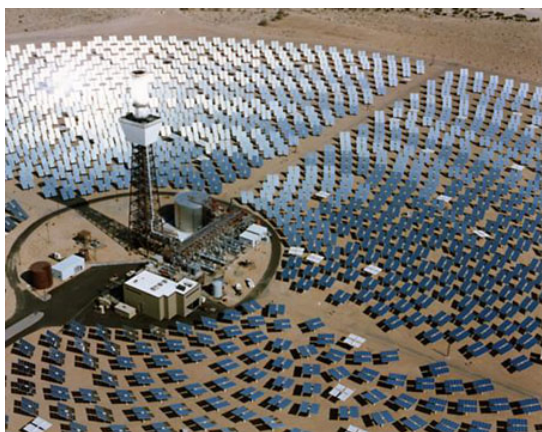
Hình 3.2. Nhà máy điện mặt trời
