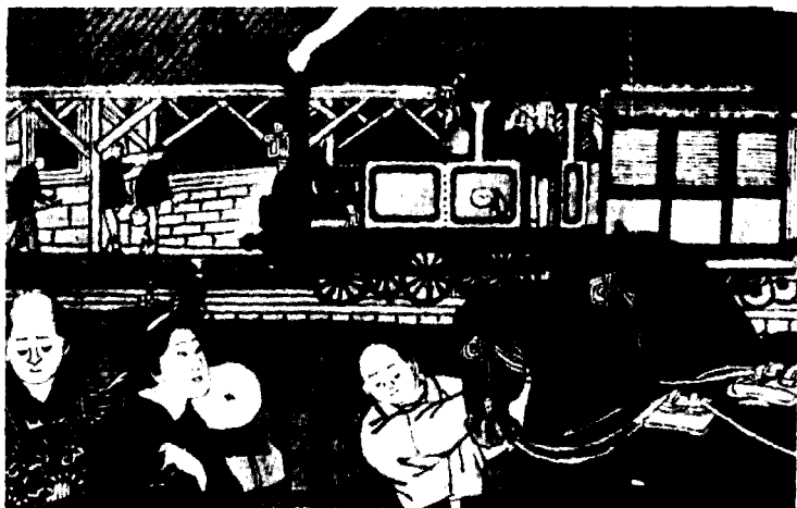
Đường sắt Tokyo-yokohama, xây dựng năm 1873
