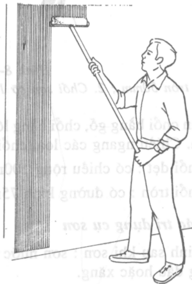
Hình 8-34 : Lăn sơn bề mặt
