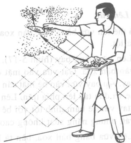
Hình 5-20 : Vẩy vữa lên tường bằng bay
