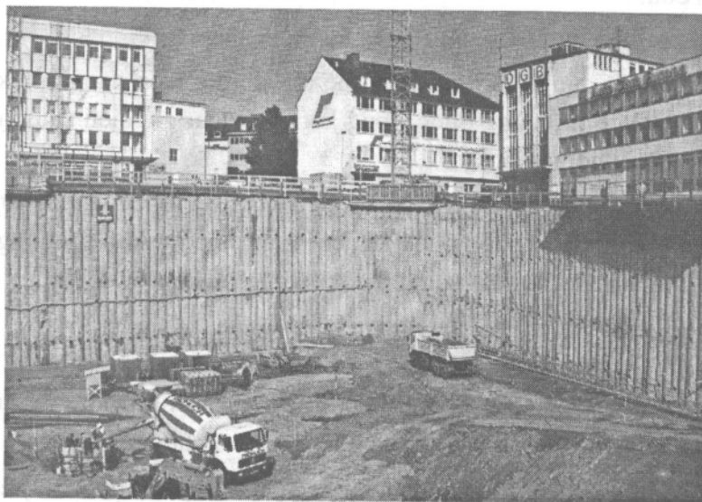
Hình 6.15. Tường chắn bằng cọc khoan nhồi đường kính 900mm + neo đất thi công bằng máy khoan BG14 trong đô thị có mật độ xây dựng cao.
