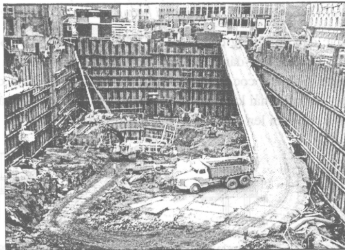
Hình 5.25: Tường cọc bản thép sâu 17-23m trong đất sét yếu ở Oslo (Na Uy)
