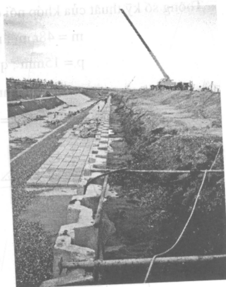
Hình 5.7. Ứng dụng cọc bản BTCT ứng suất trước ở công trình kênh dẫn nước hoàn lưu của nhà máy nhiệt điện Phú Mỹ (Bà Rịa - Vũng Tàu)
