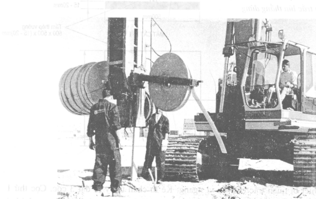
Hình 4.16: Máy cắm bấc thấm khi thi công
