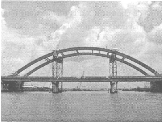
Hình 8.4. Cầu vòm làm bằng ống thép nhồi bê tông (đang thi công)
