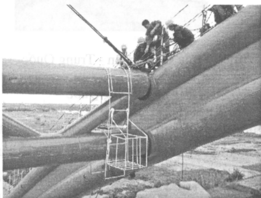
Hình 6.14. Thép tăng cường liên kết giằng ngang.
