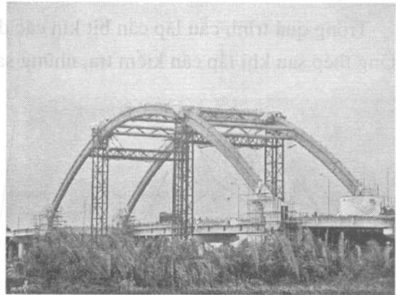
Hình 8.4. Cầu vòm làm bằng ống thép nhồi bê tông (đang thi công)
