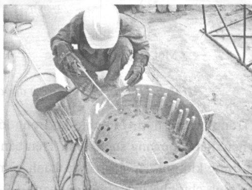
Hình 6.14. Thép tăng cường liên kết giằng ngang.
