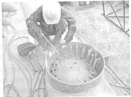
Cấu tạo chỗ nối biên vòm với giằng ngang
