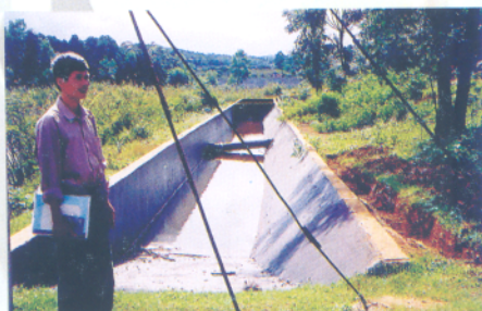
Bể lắng axit
