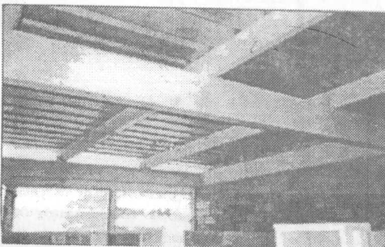
Dầm được neo xuống phía dưới bằng bu lông chạy qua tường gạch xuống móng
