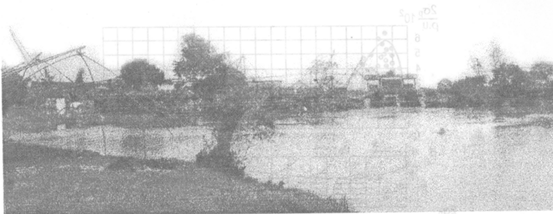
Hình 5-2: Xói ở hạ lưu cống vùng triều (cống Nhất Đồi - Nam Định)
