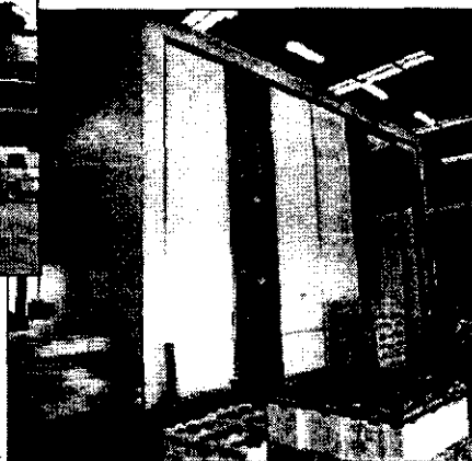
Hình 1.1. Kho bảo quản lạnh có điều chỉnh thành phần không
