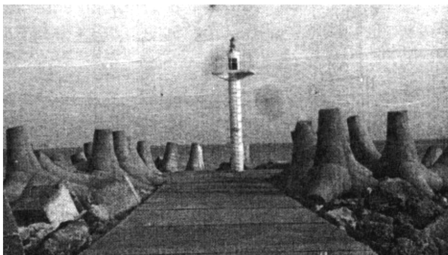
Hình 125. Hình thức kết cấu đê chắn cát, giảm sóng vùng cửa sông
