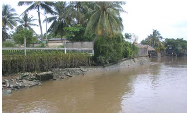
Hình 119. Kè trên sông Tiền – Khu vực chợ Gạo tỉnh Tiền Giang
