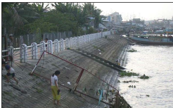
Hình 117. Công trình bảo vệ bờ sông Hậu khu vực thành phố Long Xuyên bằng khối bê tông tự chèn
