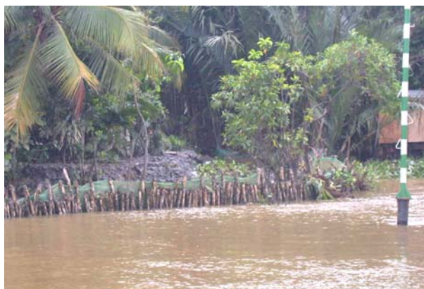
Hình 103. Loại công trình chủ động đóng ken cọc tràm nhỏ xa bờ phía trong nuôi lục bình để phá sóng
