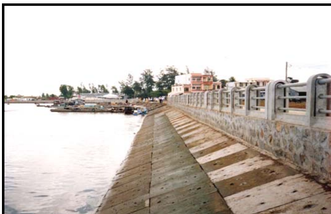
Hình 21. Kè lát mái bằng tấm bê tông thị trấn Long Toàn, tỉnh Trà Vinh
