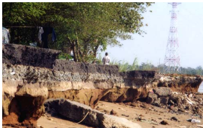
Hình 79. Hình ảnh xói lở bờ dưới tác dụng của sóng
