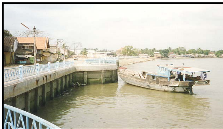
Hình 108. Kè bảo vệ bờ sông Cổ Chiên khu vực thị xã Vĩnh Long xây dựng 1996
