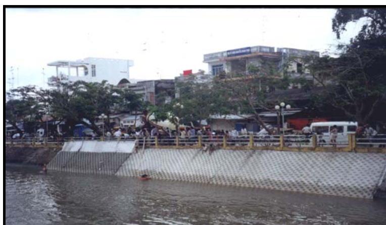
Hình 115. Thảm bê tông bơm trực tiếp trong nước bảo vệ bờ sông khu vực
