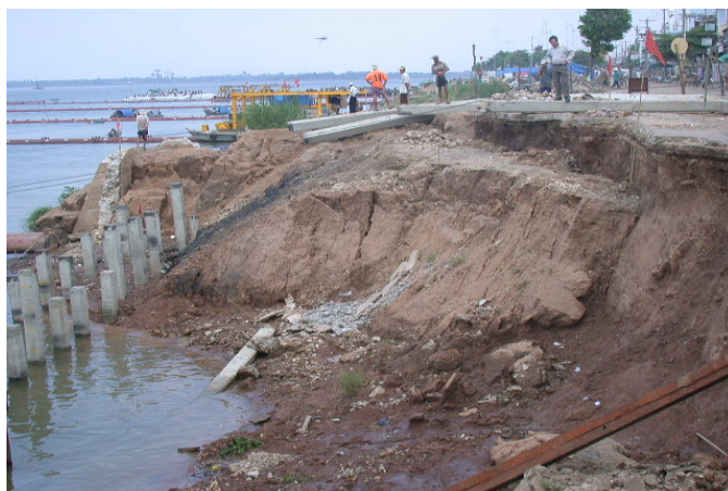
Hình 5. Công trình kè bảo vệ bờ khu vực Tân Châu đang thi công
