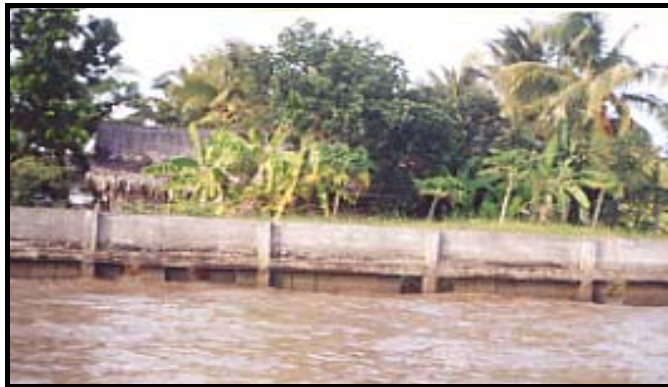
Hình 107. Kè lát mái kết hợp tường bê tông bảo vệ bờ sông Hậu, địa phận TP. Cần Thơ
