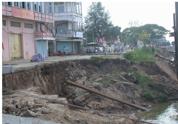
Hình 76. Xói lở bờ đoạn sông cong có hố xói cục bộ, bờ hữu sông Tiền khu vực Tân Châu
