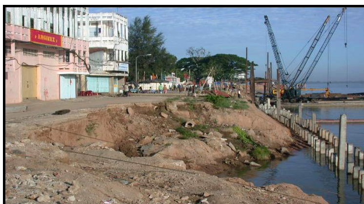
Hình 113. Hình ảnh kè khu vực thị trấn Tân Châu đang trong giai đoạn thi công
