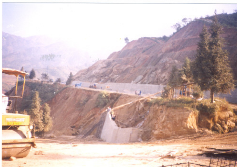
Ảnh 13: Đại công trường xử lý trượt lở tại Km118÷ 119- QL4D (phía nam cầu Móng Sến) năm 2003 (Sa Pa- Lào Cai).
