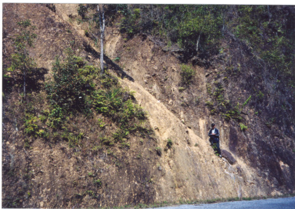
Ảnh 9: Khối trượt với mặt trượt phẳng phát triển theo bề mặt xiết ép kiến tạo tại Km114+ 600- QL279 đèo Tây Trang, Điện Biên, Lai Châu
