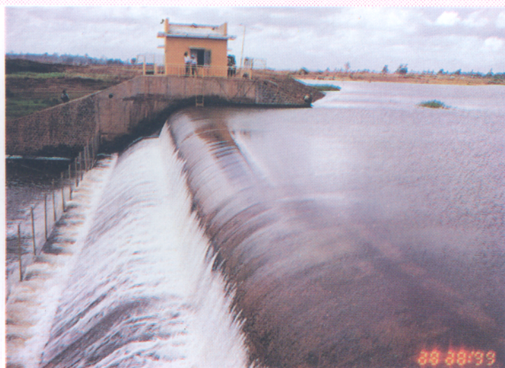
Nâng đập tràn hồ chứa bằng thân đập cao su.
