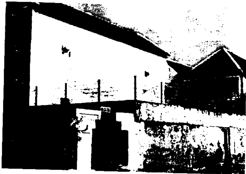
Hình 4: Nhà chim như một cái kho lớn
