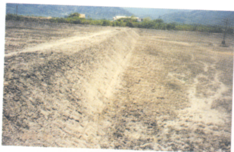
Bờ đê được xây dựng kiên cố, chắc chắn
